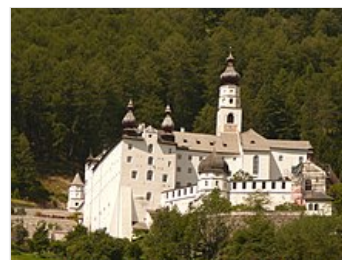
L' abbazia di Monte Maria , presso Burgusio di Malles
