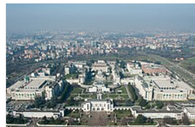
Vista dall'alto dell' Ospedale Niguarda Ca' Granda di Milano
